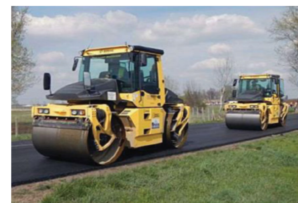
Công tác thảm Bê tông nhựa nóng Quốc lộ 14
