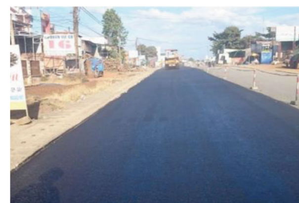
Công tác thảm Bê tông nhựa nóng Quốc lộ 91
