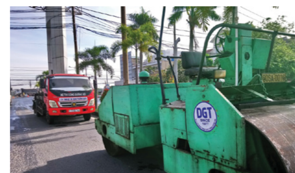
Cung cấp bê tông nhựa nóng cho khu CN Biên Hòa 2
