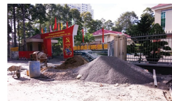
Công trình trung tâm hành chính huyện Long Thành
