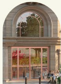
Cửa nhôm Eurowindow hệ E100, độ dày nhôm 3mm
